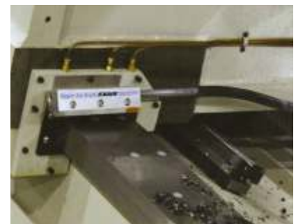
Eliminación de las virutas en cintas, rieles y elementos de máquina con el objetivo de evitar el desgaste prematuro de las mismas
